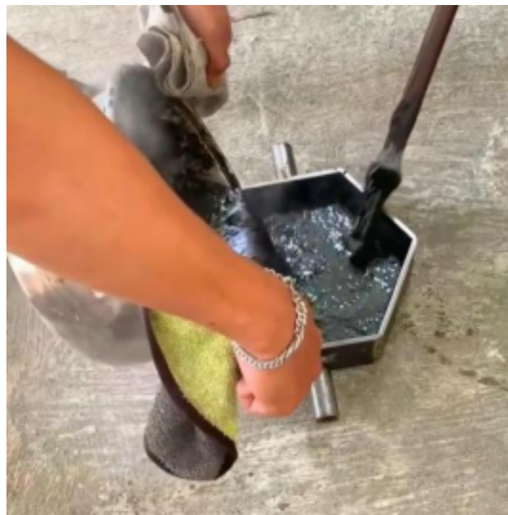
Gambar 7 . Proses Pencetakan Paving
