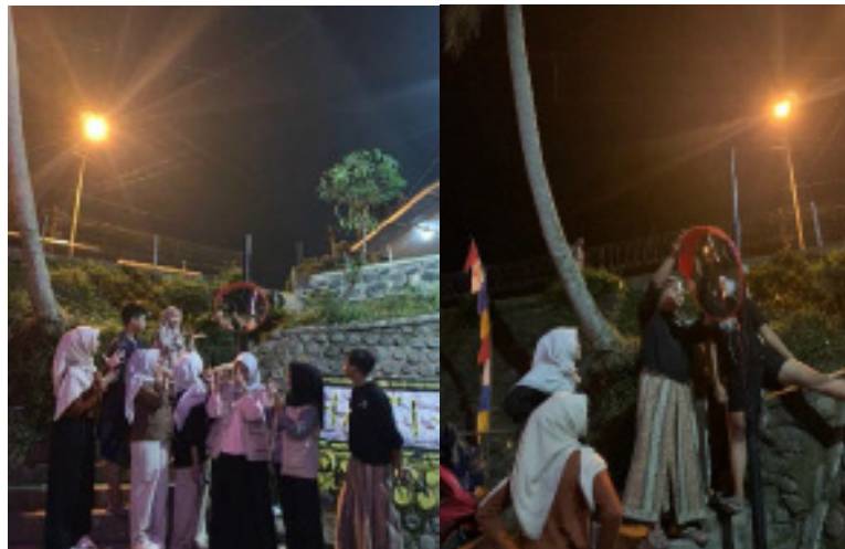
Gambar: pemasangan convex mirror di RT 04 RW 04
