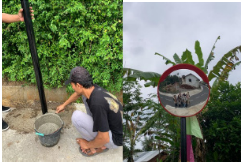
Gambar: Pemasangan tiang dan Convex mirror di RT 01 RW 01
