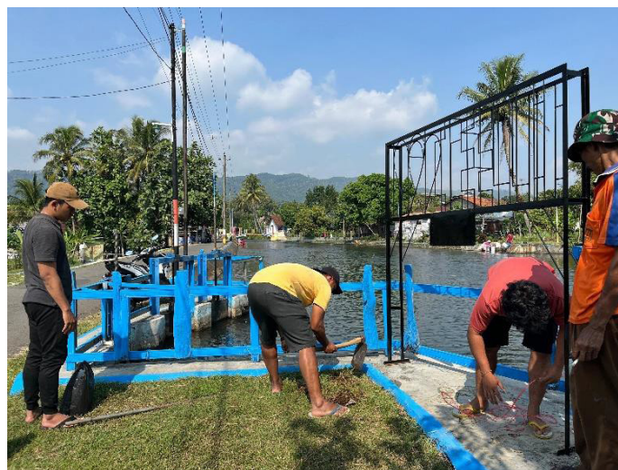
Gambar 3.3 proses pemasangan kerangka spot foto ekobrick
