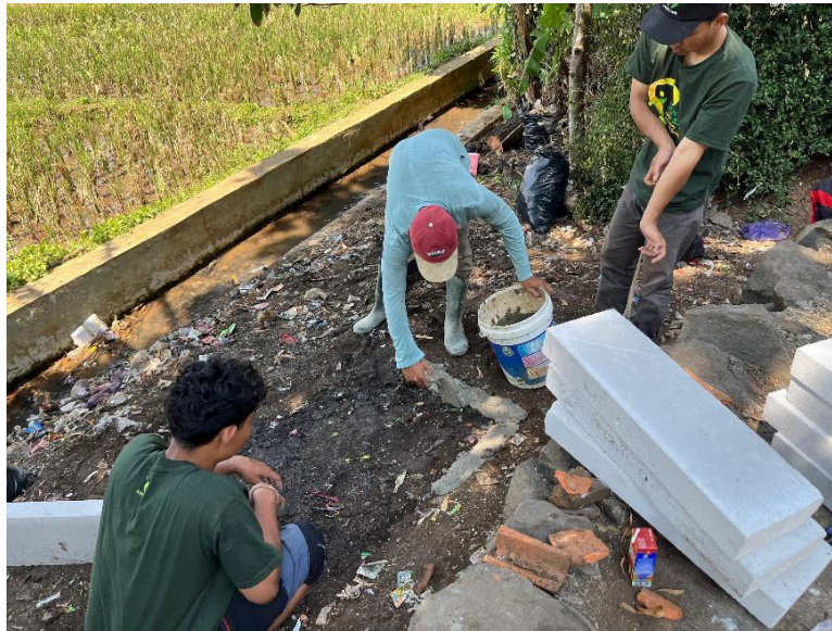
Gambar 3. Pembangunan ZEROPA (Zona Reduksi Sampah)
