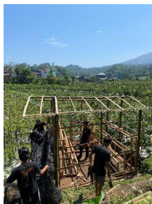
Gambar 3. Green House Pemasangan UV.
