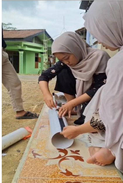
Gambar 4. Proses pembuatan pipa dan mempersiapkan alat- alat untuk pembuatan biopori
