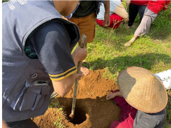
Gambar 8. Proses pembuatan lubang biopori
