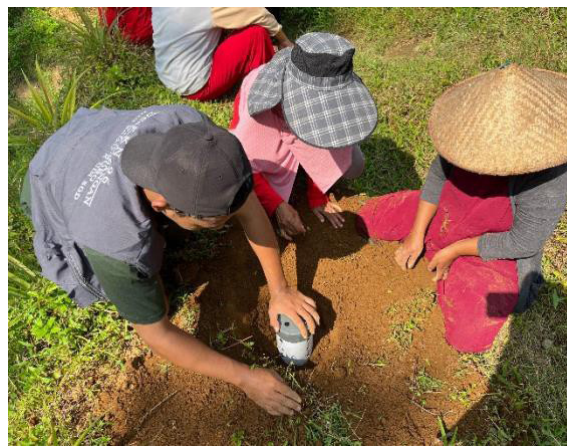
Gambar 9. Proses memasukkan pipa ke lubang biopori
