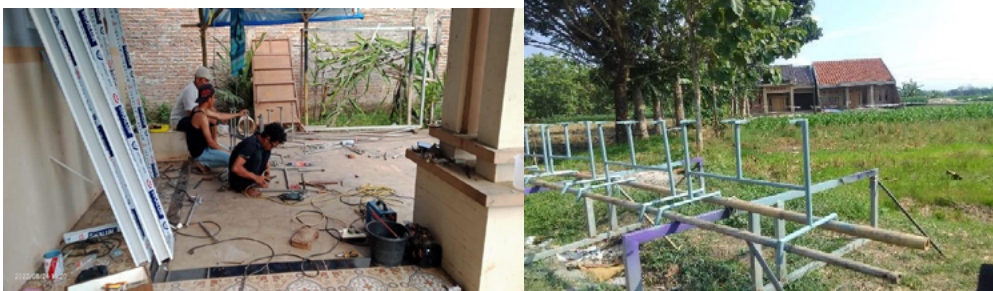
Proses pembuatan kerangka tempat sampah.
