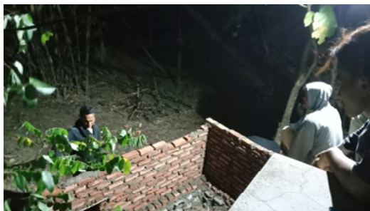
Gambar 3.4. Proses Pembuatan Tempat Pembuangan Sampah di RW 05 Dusun Caruy
