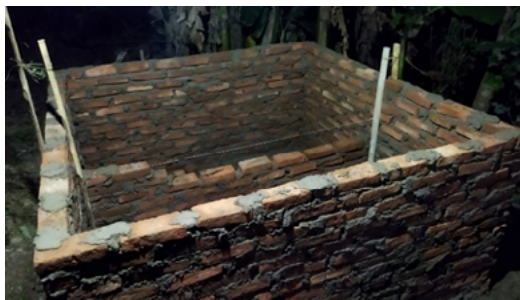
Gambar 3.3 Proses Pembuatan Tempat Pembuangan Sampah di RW 04 Dusun Bulaklega
