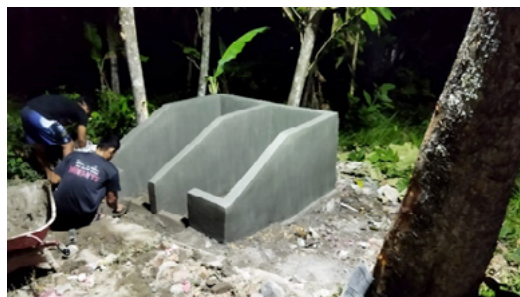
Gambar 3.2. Proses Pembuatan Tempat Pembuangan Sampah di RW 01 Dusun Cikamuning
