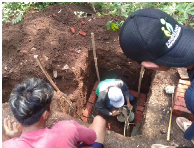
[Gambar 4] proses membuat tembok sumur
