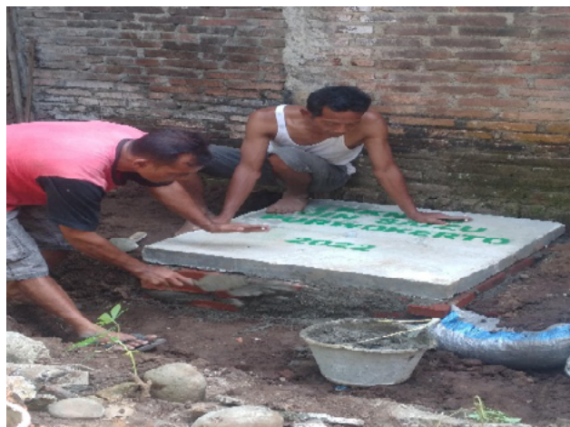
[Gambar 5] proses pemasangan tutup SPAL
