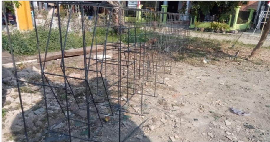
**Gambar 4.** Pembuatan Kerangka
