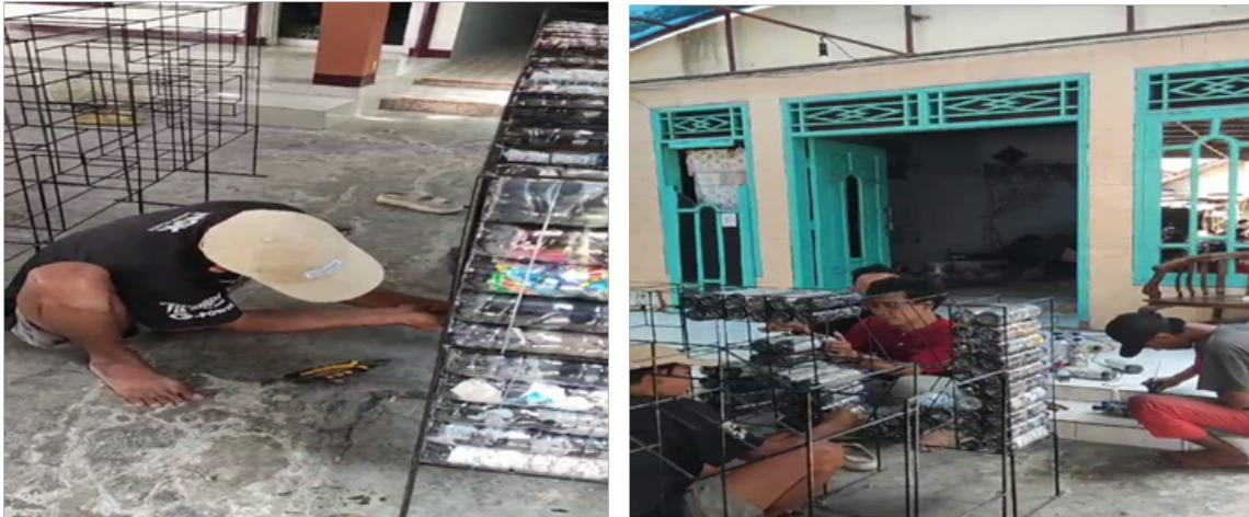
**Gambar 6.** Pemasangan Ecobrick pada kerangka
